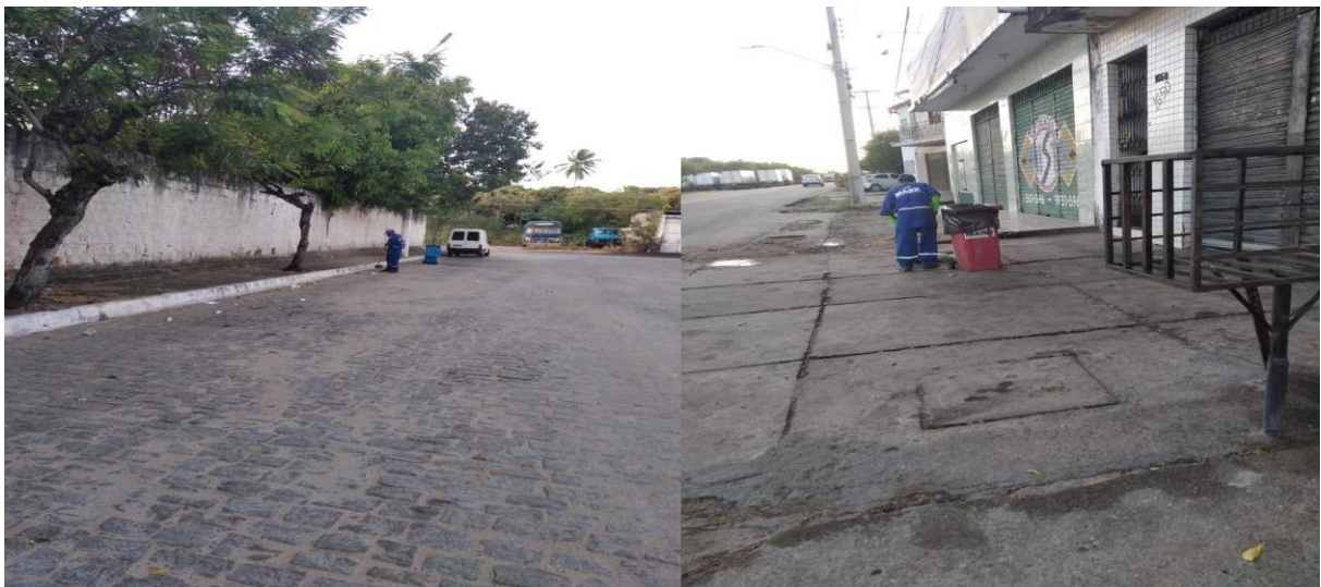
Figuras 06 – 07: serviços de limpeza manutenção de elementos de drenagem superficial.
