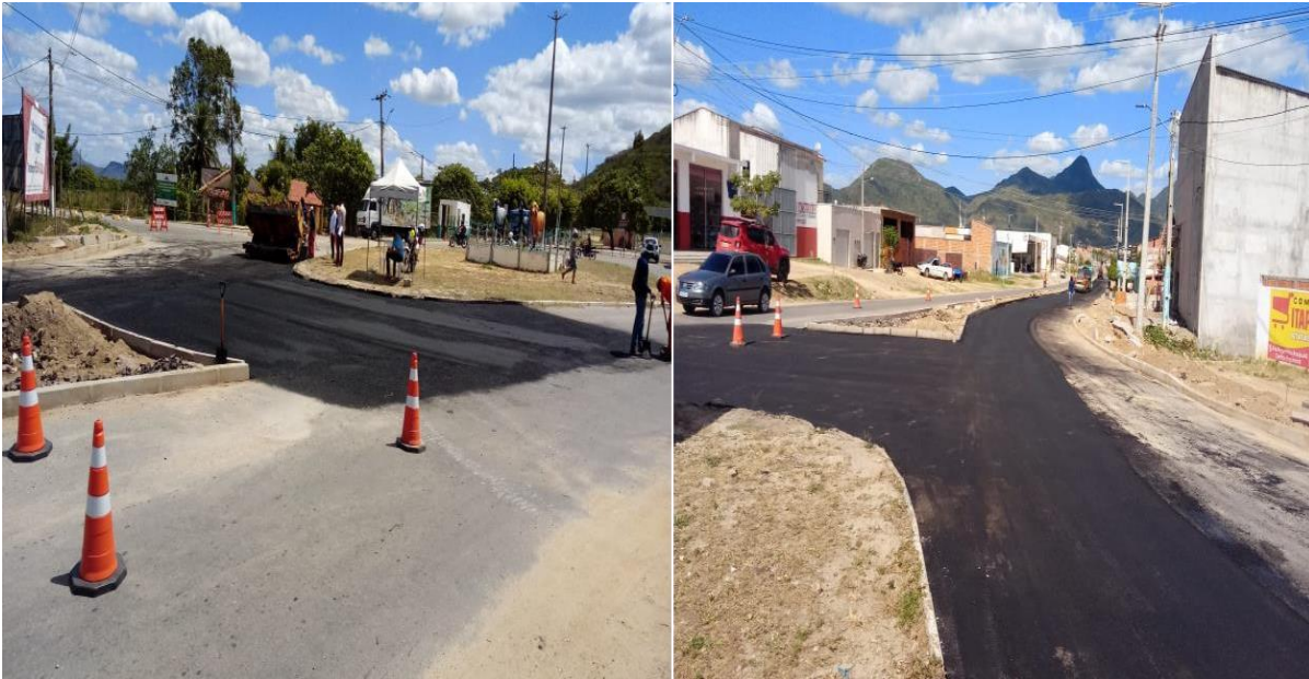
Figuras 08 – 09: serviços de ampliação do sistema de microdrenagem
