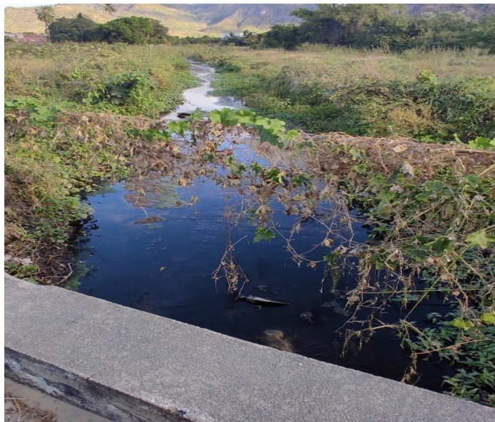
Figura 11: Trecho de macrodrenagem assoreado, córrego Riacho das Almas, Bairro Estação.
