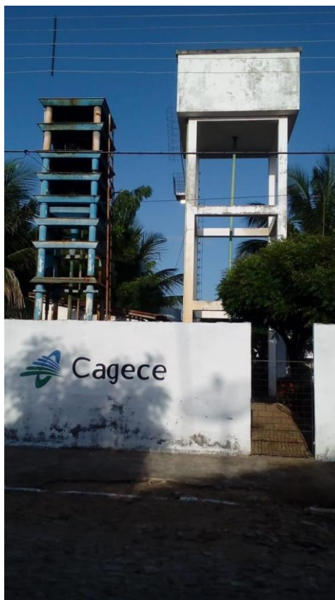
Figura 49 - Fachada da Eta Betânia, distrito Cruxati, no município de Itapipoca – CE.
