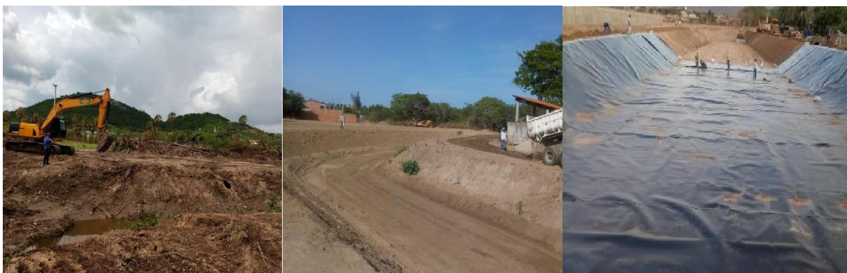
Figuras 12 – 14: Obra de desassoreamento e alargamento do córrego Riacho das Almas
