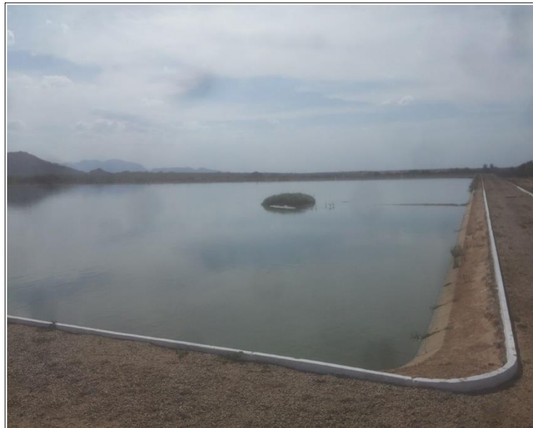
Figura 60 - Vista lateral da Lagoa Facultativa do SES da Sede do município de Itapipoca – CE.
