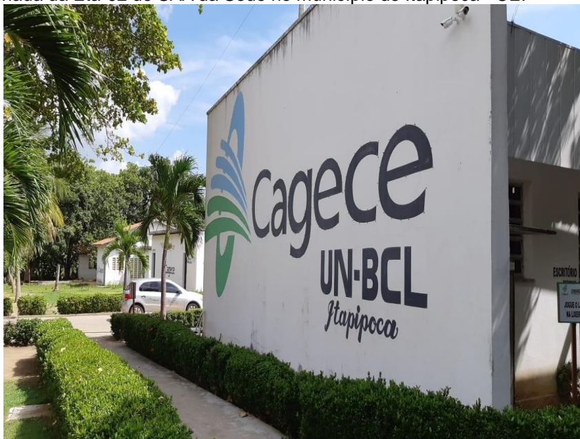
Figura 24 - Fachada da Eta-02 do SAA da Sede no município de Itapipoca - CE.
